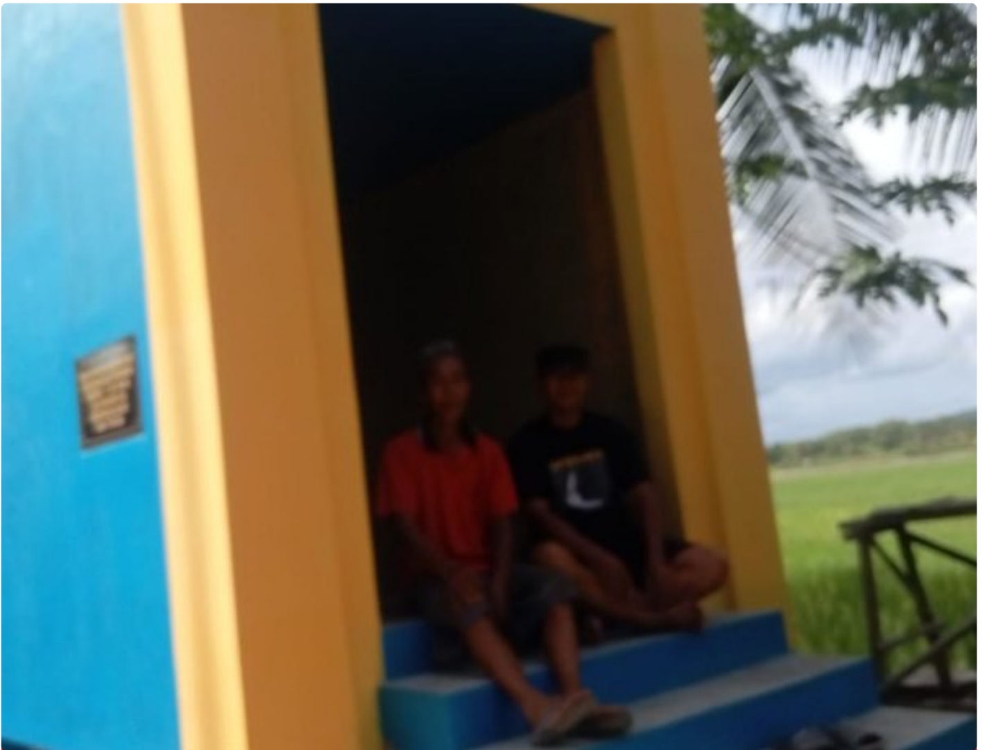
Pembangunan Irigasi Perpompaan di Desa Binangun
